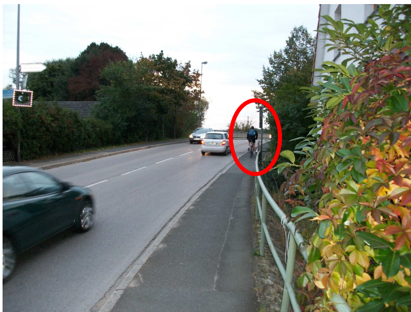
Abbildung 16: ERH 31 mit Blickrichtung auf die Regnitzbrücke
