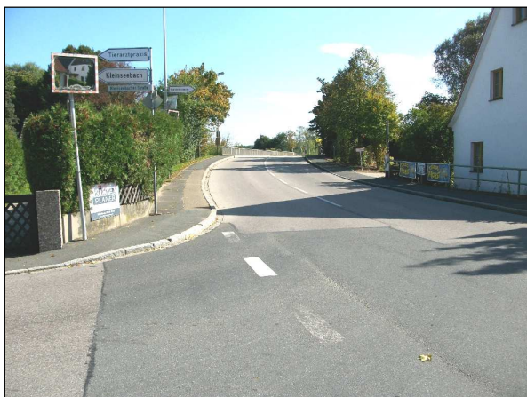
Abb. 12: ungenügende Anfahrtsicht nach Osten
