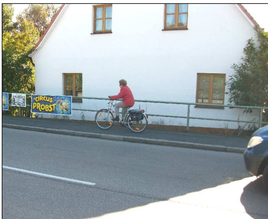
Abb. 33: ERH 31 Ost, Südseite
